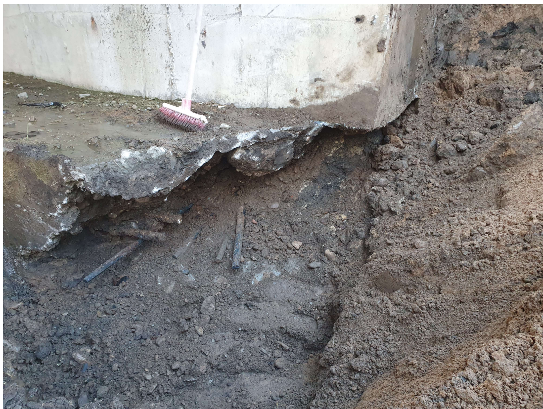
Foto 4: Stav základové konstrukce opěry mostu.
