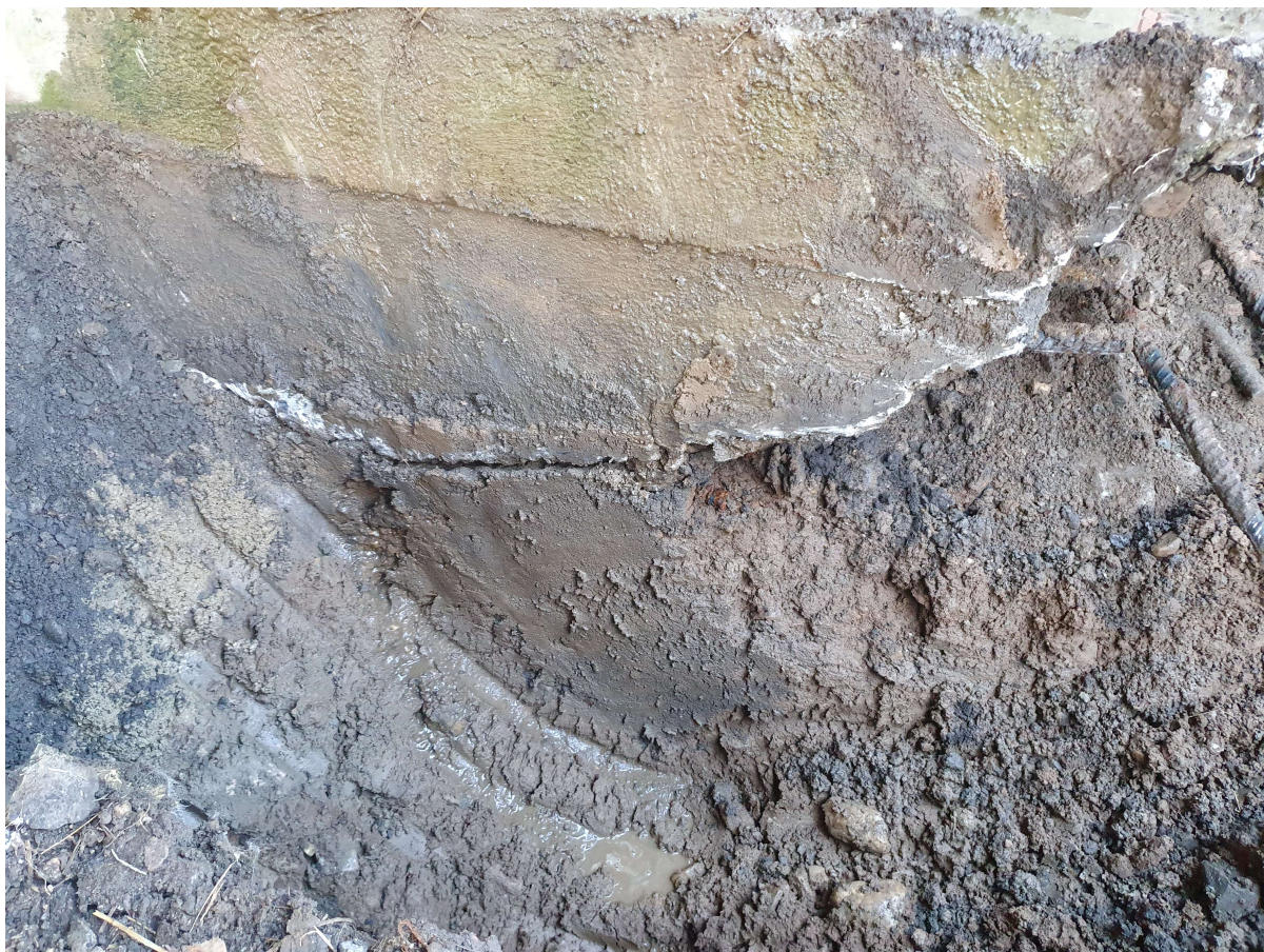
Foto 5: Stav základové spáry opěry mostu.
